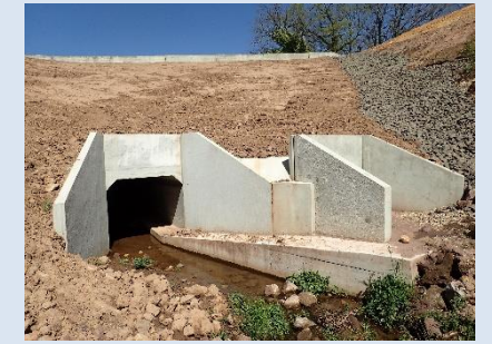
Ouvrage hydraulique (BKM)
