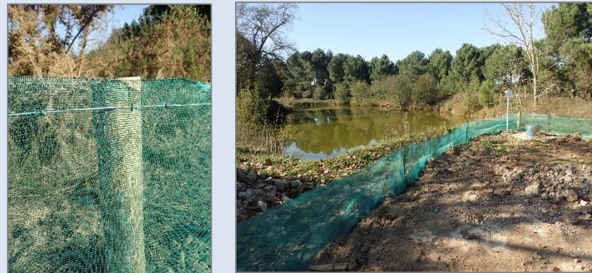
Filet temporaire enterré, pose mécanique (BKM)
