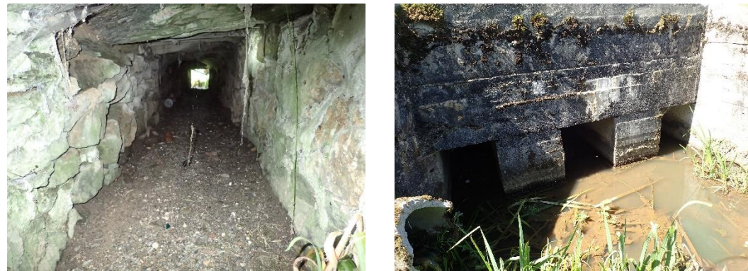
Figure 9 : Ouvrage hydraulique situé en aval de l'étang de la Vézérie
